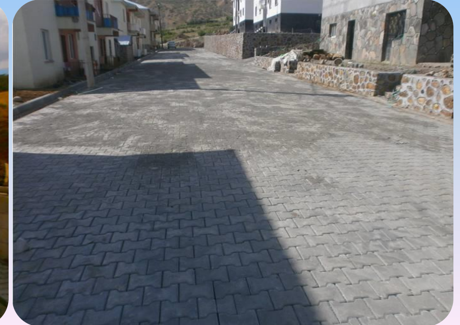
MERKEZ EKİNYOLU ADA İÇİ YOL
