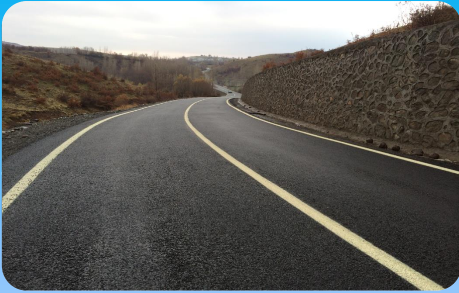
MERKEZ SARIÇEK HAVAALANI GRUP KÖYYOLU BSK ASFALT
